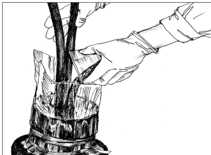
Рис. 3.5. Заливка герметика ВИЛАД-31 в горловину муфты МПЗ
